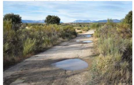
PERFILADO DEL CAMINO Y RASANTEO DE LA SUPERFICIE, CON APORTACIÓN DE ZAHORRA PARA CONDUCIR ESCURRENTÍAS HACIA CUNETAS
